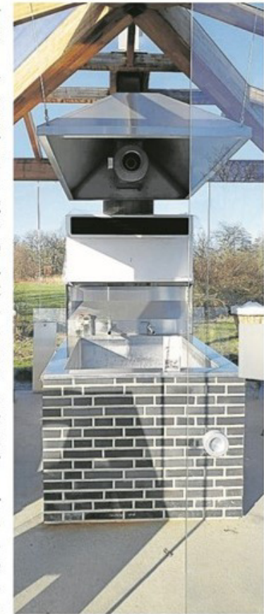
Eine neue Entlüftungsanlage sorgt im Salinenpark für günstigere Klimabedingungen. Foto: Förderverein Saline Gottesgabe
